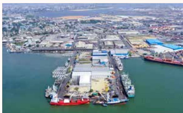
Le môle du terminal à pêche après travaux
