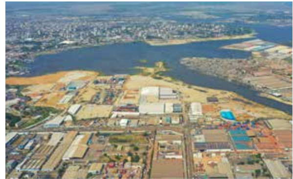
La baie lagunaire de Vridi-Biétry après la création de terrains par remblaiement
