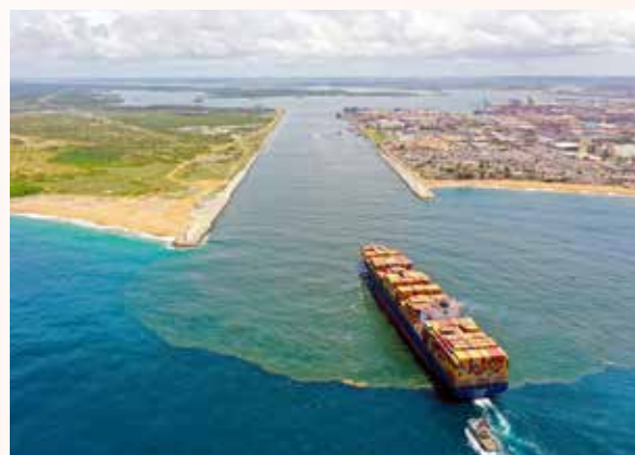
Le canal de Vridi après travaux
