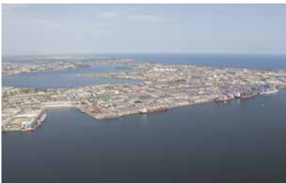
Le terminal roulier avant travaux
