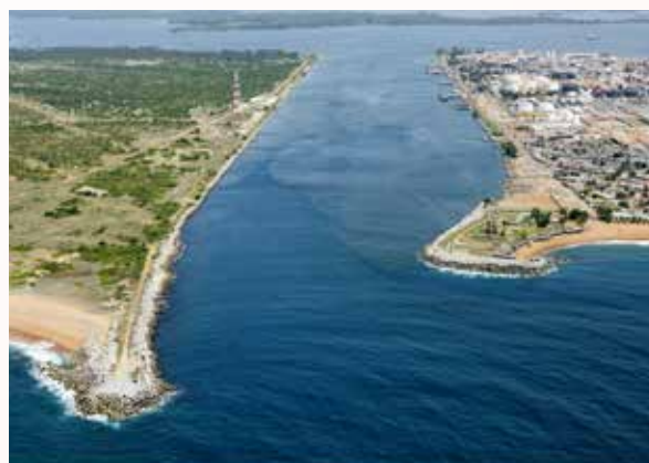
Le canal de Vridi avant travaux
