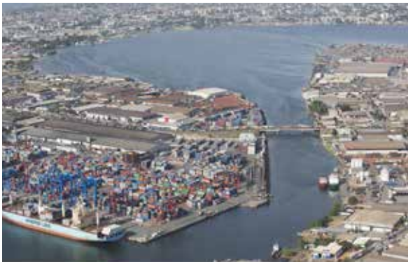
La baie lagunaire de Vridi-Biétry avant travaux
