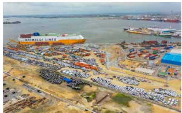
Le terminal roulier après travaux
