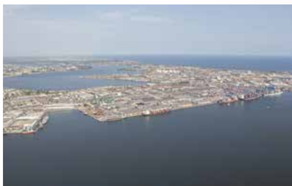
Le site du deuxième terminal à conteneurs avant travaux
