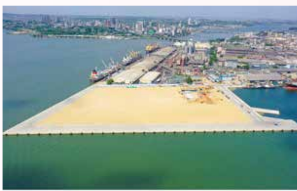
Le terminal céréalier en mars 2023, à 99,5% de taux de réalisation
