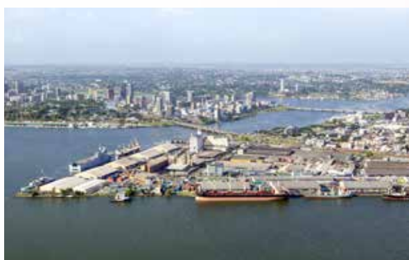
Le site du terminal céréalier avant travaux
