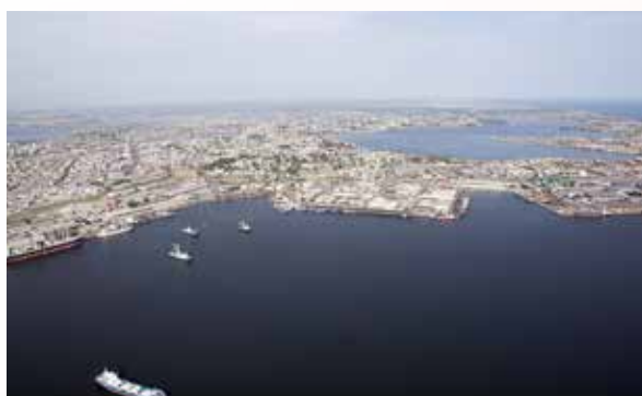
Le môle du terminal à pêche avant travaux
