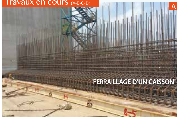
Travaux en cours (A-B-C-D)
