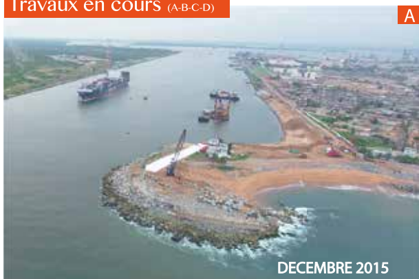
Travaux en cours (A-B-C-D)
